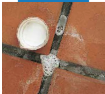
Limpeza de eflorescencias
